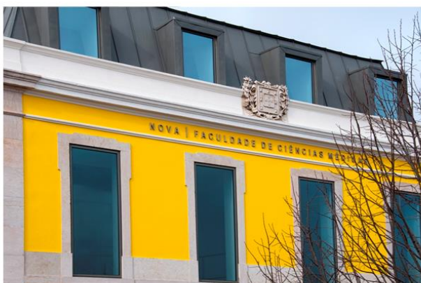
O Edifício amarelo do CEDOC-NMS|FCM
