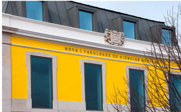
O Edifício amarelo do CEDOC-NMS|FCM
